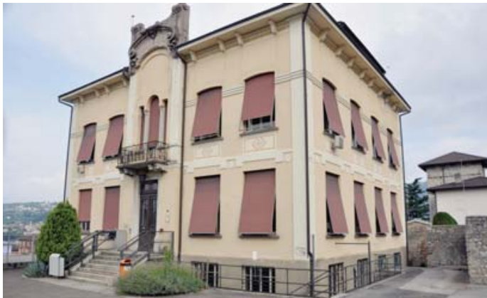
La "storica" e amata Palazzina in Piazzale Municipio a Mendrisio sarà la nuova sede della Scuola di Musica del Conservatorio della Svizzera Italiana (sede Mendrisio), con una superficie di oltre 400 metri quadrati.
